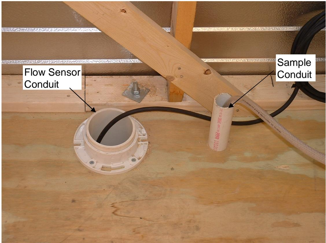
f. Sample and Sensor Cable Conduits
